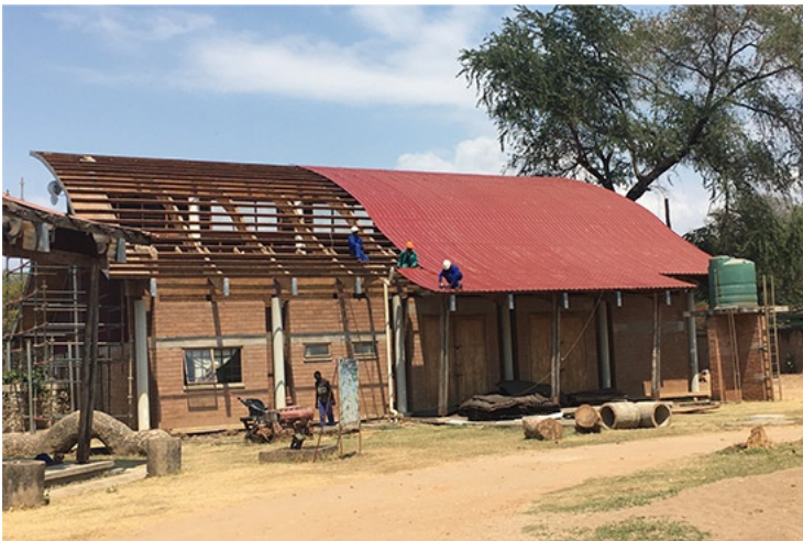
Die Erneuerung konnte nur während der Trockenzeit (Mai bis November) erfolgen.
