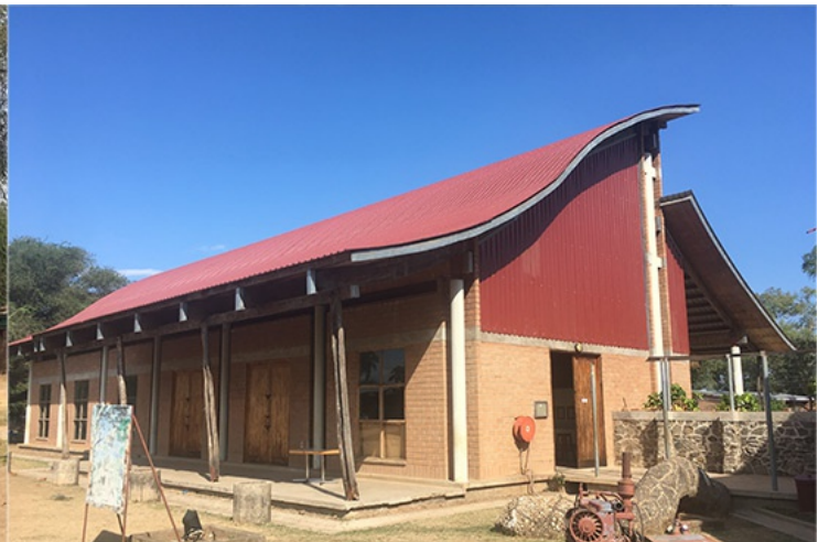
Nachher: Das Dach behält seine charakteristische Form und Farbe.
